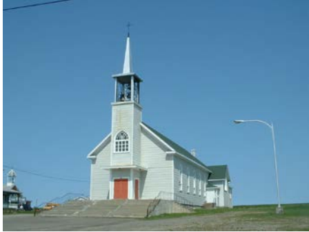
Église vue de l'extérieur
